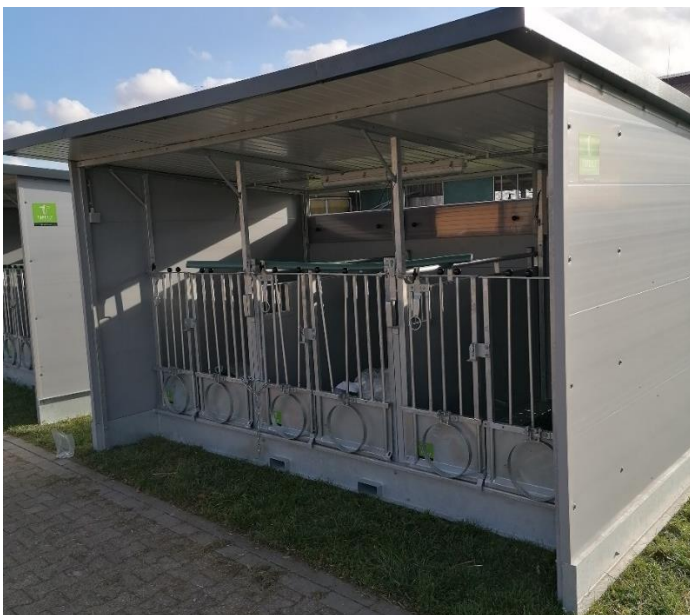
Abbildung 3: Kälberhütten mit Möglichkeit zur Einzel- und Gruppenhaltung durch herausnehmbare Trennwände
